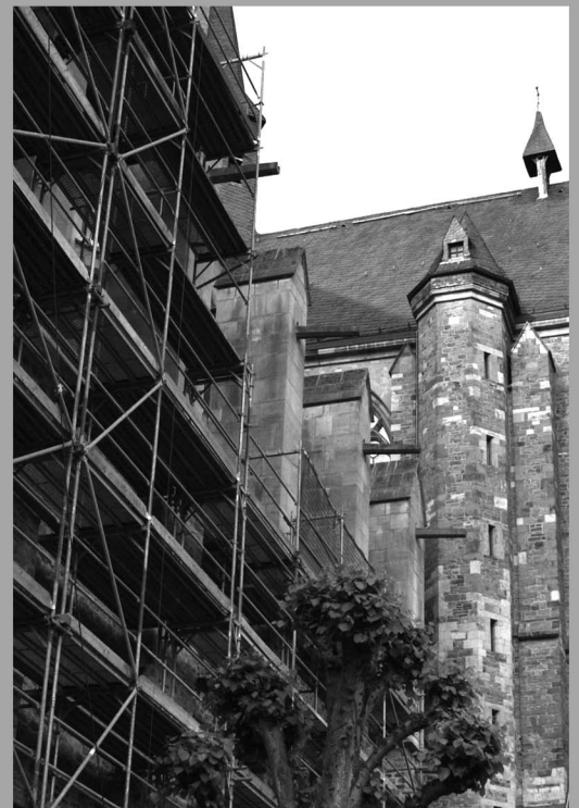
Klar zu sehen: Schandfleck Backsteinbau stört die Aura des Gerüsts
